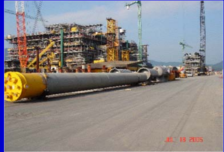
Disposal Sump Caisson
